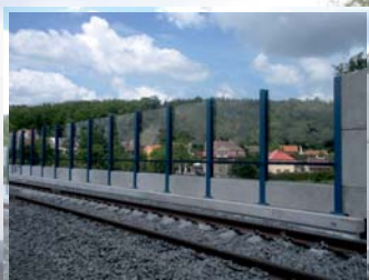
Protihluková stěna Kyje
