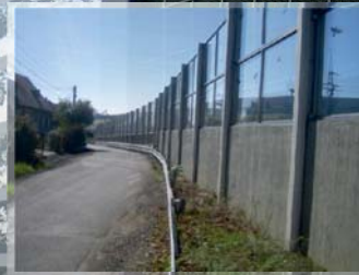
Protihluková stěna Jeřmanice
