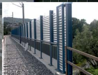
Protihluková stěna ŽST Čerčany
