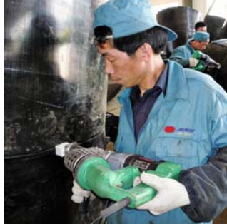
Přístroj FUSION 2 při výrobě nádrže.
